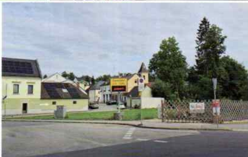
Abrisse baufälliger Gebäude
