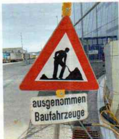
Linz (OÖ). Wann die Arbeiten an dieser Baustelle im Hafenviertel wohl fertig sind? Alles muss hier händisch geschehen. Foto: Birgit Häusler
